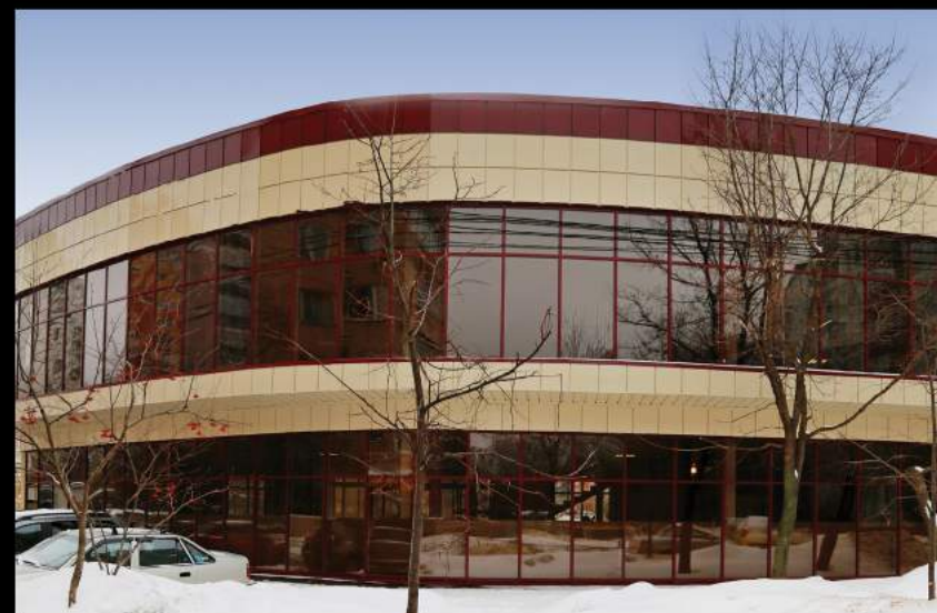
ТОРГОВЫЙ ЦЕНТР В Г. ХИМКИ. ФАСАД - СТАЛЬНЫЕ ФАСАДНЫЕ КАССЕТЫ С ПОРОШКОВОЙ ПОКРАСКОЙ 780 КВ.М
