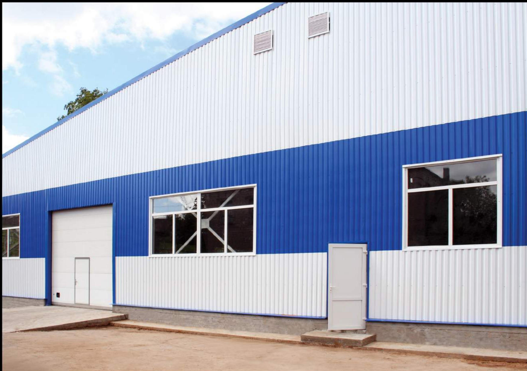
ЗДАНИЕ ЗАВОДА В Г. УГЛИЧ 2600 кв.м
