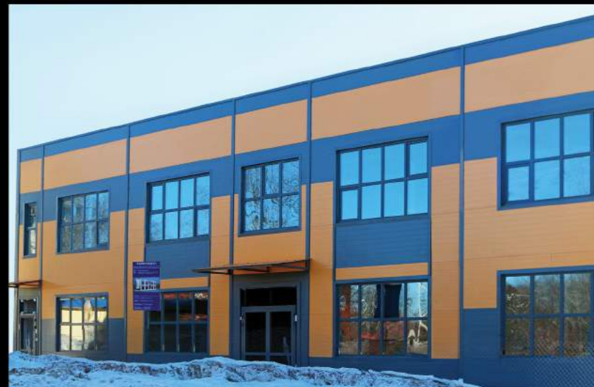
ТОРГОВЫЙ ЦЕНТР В Г. ЩЁЛКОВО. ФАСАД - СЭНДВИЧ-ПАНЕЛИ 475 КВ.М
