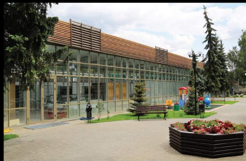
ТОРГОВЫЙ ЦЕНТР В Г. ХИМКИ. ФАСАД - АЛЮМИНИЕВЫЕ ВИТРАЖИ 800 КВ.М
