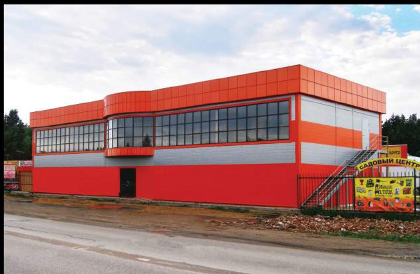
ТОРГОВЫЙ ЦЕНТР В ПОСЁЛКЕ ОСТАНКИНО ДМИТРОВСКОГО РАЙОНА. ФАСАД - СЭНДВИЧ-ПАНЕЛИ И СТАЛЬНЫЕ ФАСАДНЫЕ КАССЕТЫ 700 КВ.М
