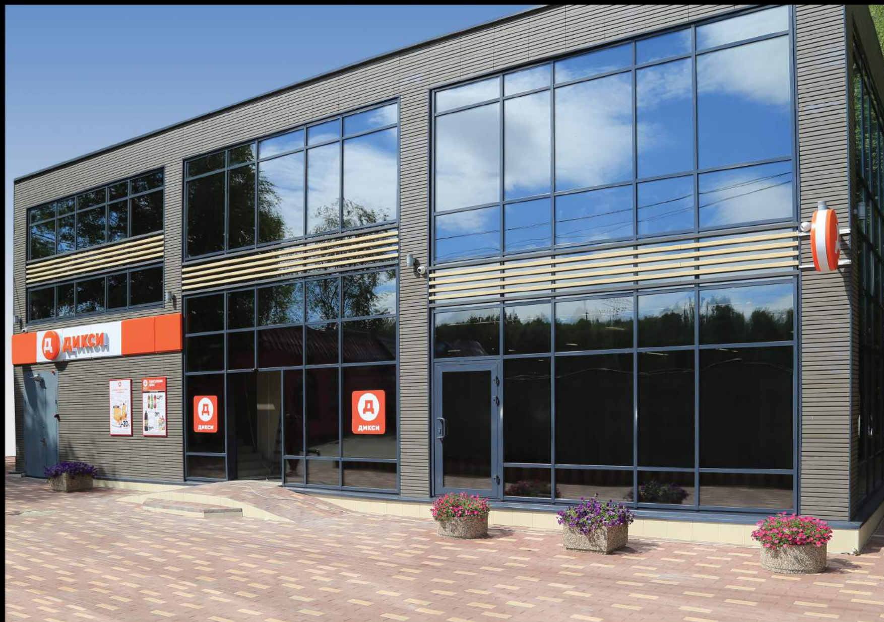
ТОРГОВЫЙ ЦЕНТР В Г. ХИМКИ. ФАСАД - ТЕРРАКОТОВАЯ ПЛИТКА 600 КВ.М
