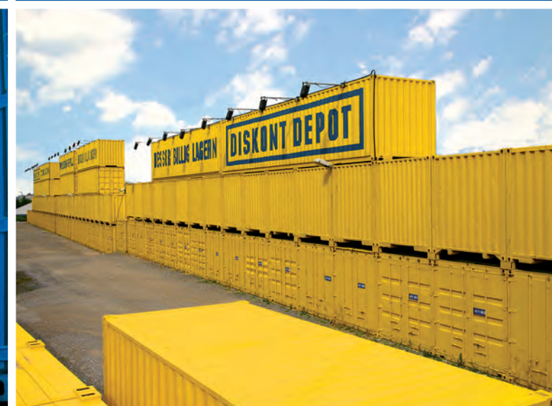
Сооружение для самостоятельного складирования
